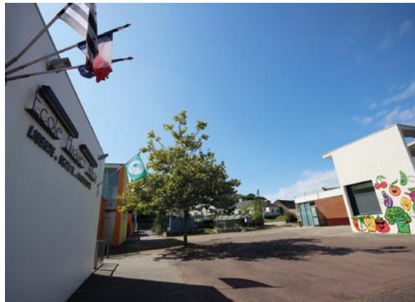
Le bâtiment sera situé entre les deux écoles et à proximité du restaurant scolaire.
